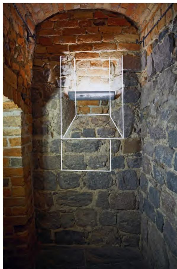
Abb. 7 Hauptstraße 9, Keller; Flur Raum 2, südliche Stirnwand mit Fenster. Weiß umrandet unten: aufgebene (Fenster?) Nische, oben: ausgeführtes geschrägtes Fenster. 2023 (Foto: J. Müller).
