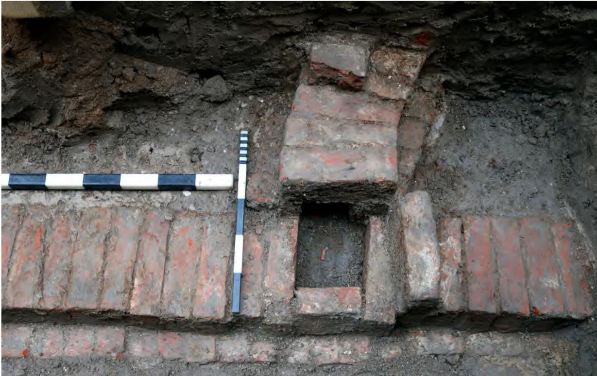
Abb. 10 Einführung eines Hausanschlusses in den Backsteinkanal (Bereich Archäologie und Denkmalpflege der Hansestadt Lübeck).
