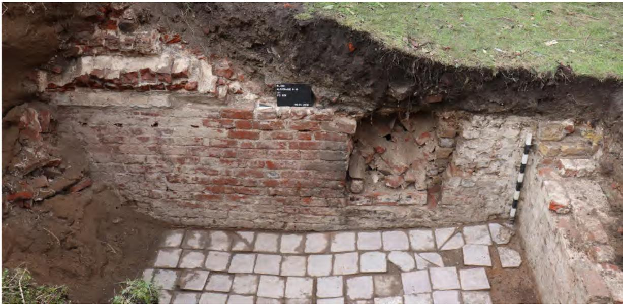
Abb. 6 Mauerdurchbruch in der mittelalterlichen Brand-/Kellermauer zwischen den Grundstücken Alfstraße 12 und 14 als Schutzmaßnahme vor Verschüttung im Falle eines Luftangriffs.
