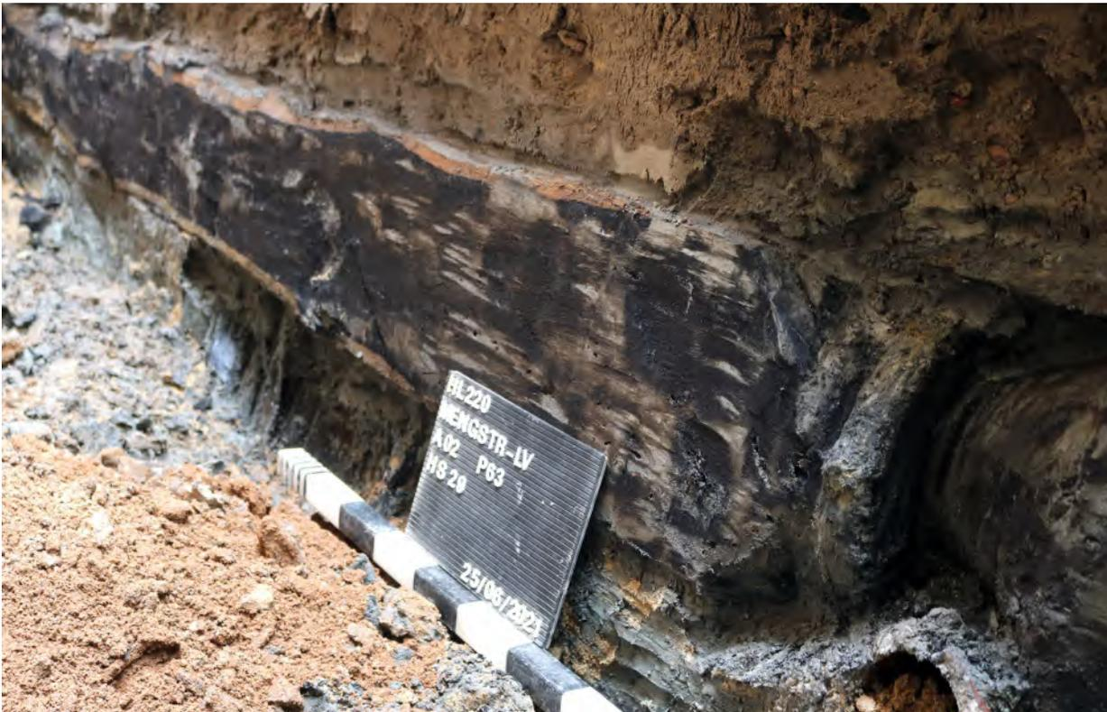
Abb. 8 Rohrsegmente der „Bürger- und Kaufleutewasserkunst“, DD1530, aus längs durchbohrten Holzbalken. Rechts Verbindung zwischen den Segmenten. Unten hölzerne Baugrubenaussteifung des Kastenbrunnens (Bereich Archäologie und Denkmalpflege der Hansestadt Lübeck).
