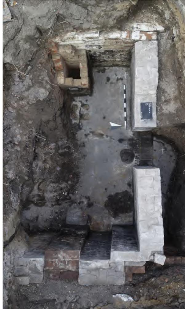
Abb. 4 Keller im Vorderhaus von Alfstraße 18: spätmittelalterliche Brandmauer (links) mit modernem Schornstein, Umbauten des 19. Jh. (rechts) und die Kalksandsteinmauerwerke des Luftschutzkellers (Mitte).
