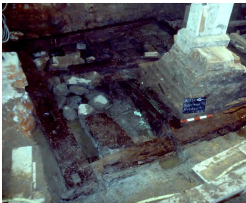
Abb. 8 Lübeck. An der Untertrave 98. Schwellen-Ständerbau von „1186“ (Per. II); vorne links: Überblattete Grundswellen mit Zapfenloch für den Eckständer der NW-Ecke; innen: Verstürzte Bauelemente über den Unterzügen des Bretterbodens sowie eines der 17 Pfeilerfundamente des Neubaus von 1870.
