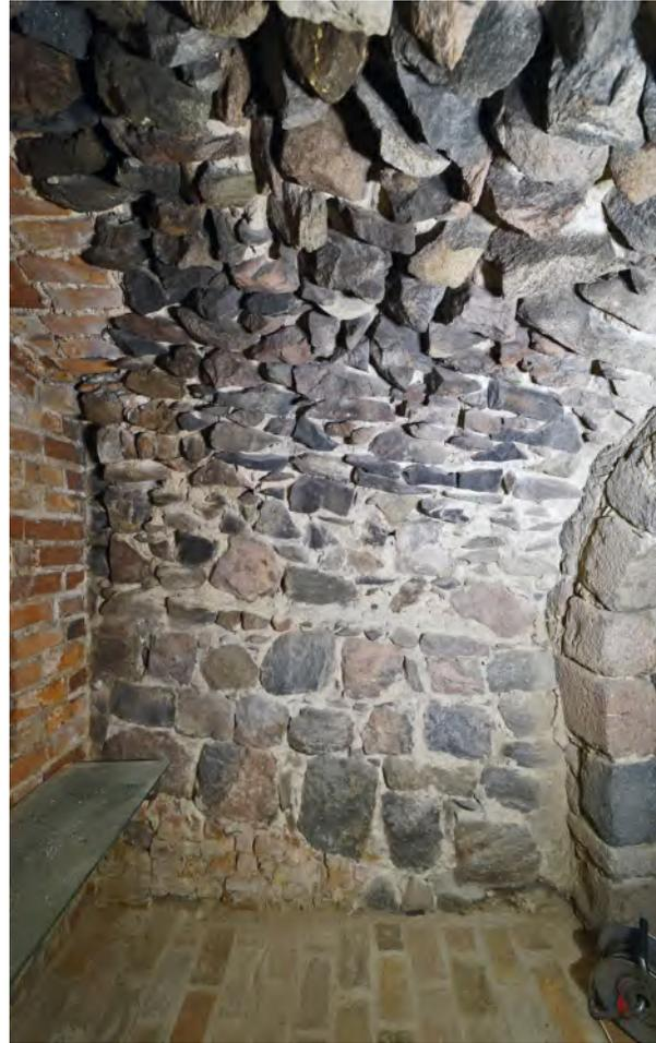
Abb. 9 Hauptstraße 9, Keller, Vorraum 4 mit Tonnengewölbe, nach Norden zur Straße ansteigend Fußboden, Kämpfer und Gewölbescheitel, links Ausbruch eines Bogens. 2023 (Foto: J. Müller).
